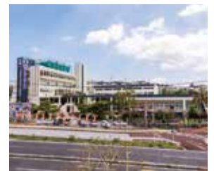
(財)沖縄県医療福祉事業団 施設外壁塗替塗装工事
